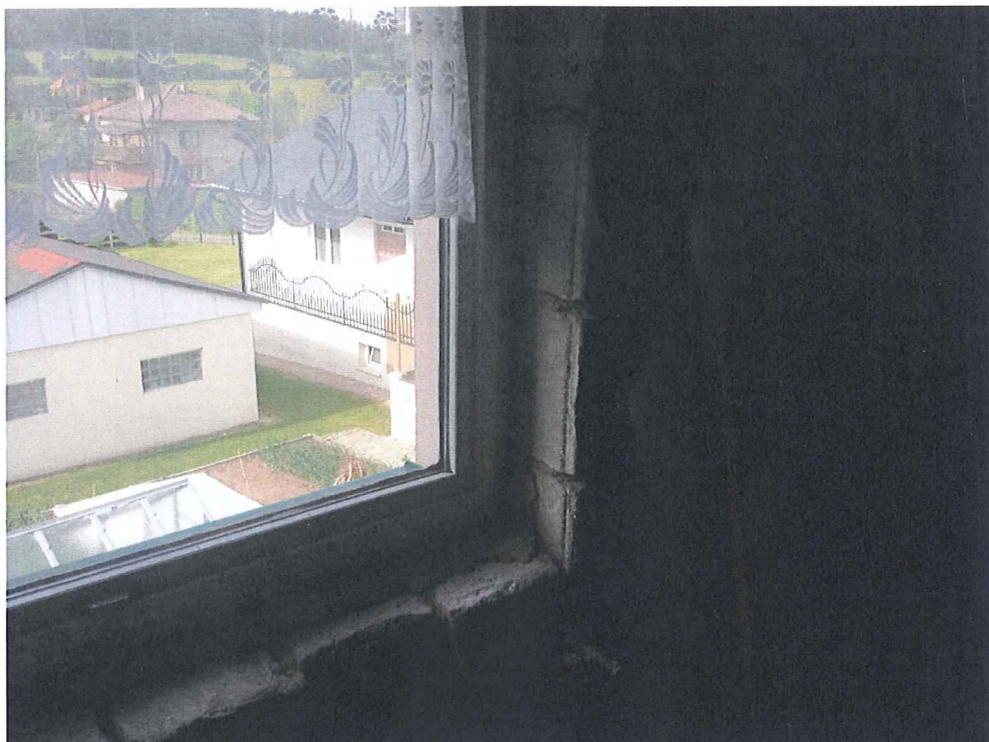
Neomítnuté stěny v podkroví
