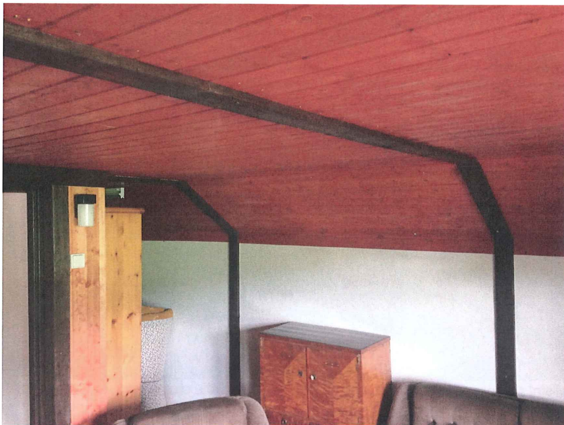
Obklad stropu „letního pokoje“ v 2.NP
