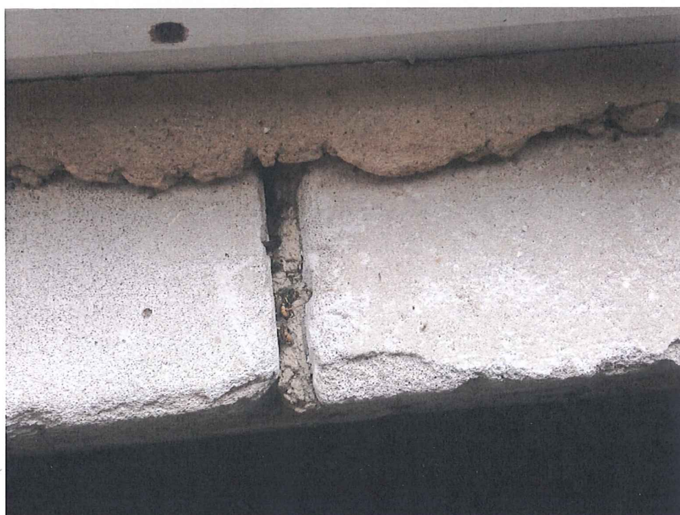
Neomítnuté stěny v podkroví
